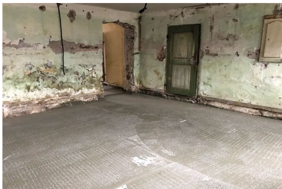
Frühe Arbeiten: Die Verklammerung eines Setzungsrisses im Mauer- werk der Südseite. Wichtige Sicherungsmaßnahmen und erste Reparaturen am historischen Mühlpodest. Und zudem ein Blick in die heutige Küche und Stube nach Einbringung der Bodenplatte.
