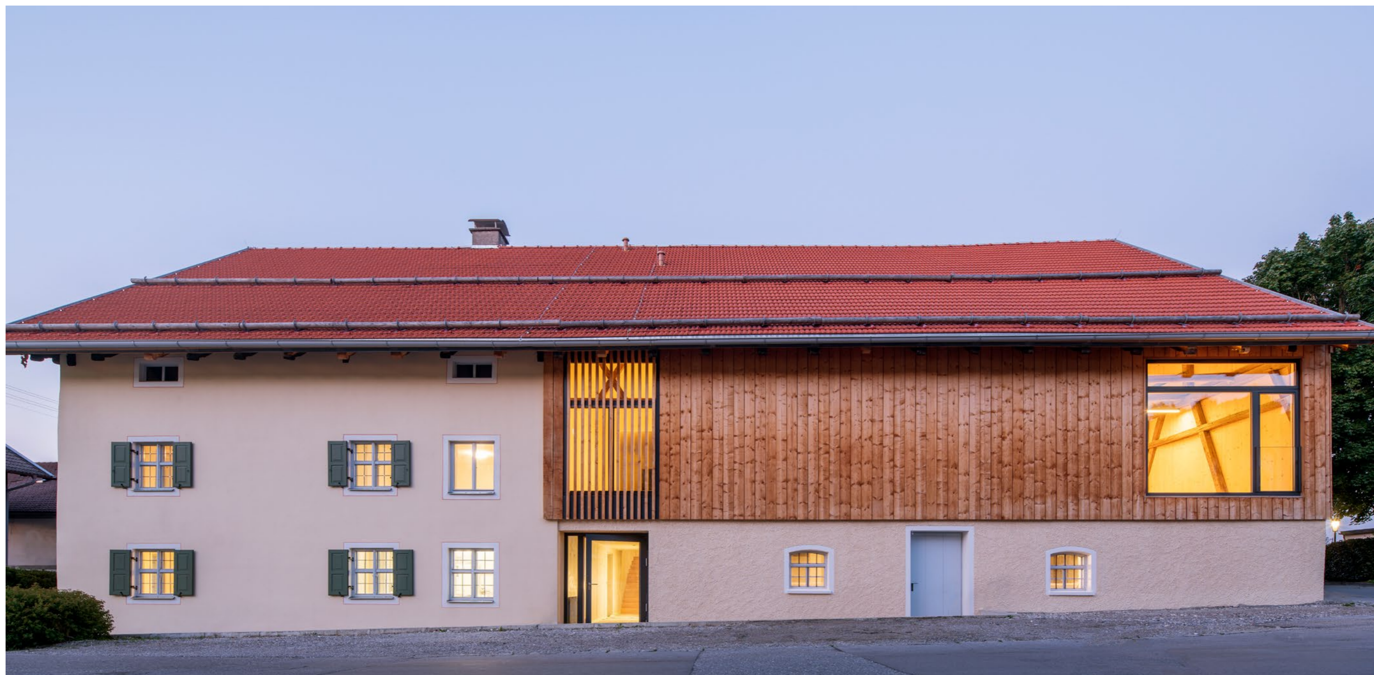
Gesamtansicht des Lamplhofes. Links der ehemalige Wohnbereich, rechts Stall und Tenne in neuem Gesicht und mit neuer Nutzung.
