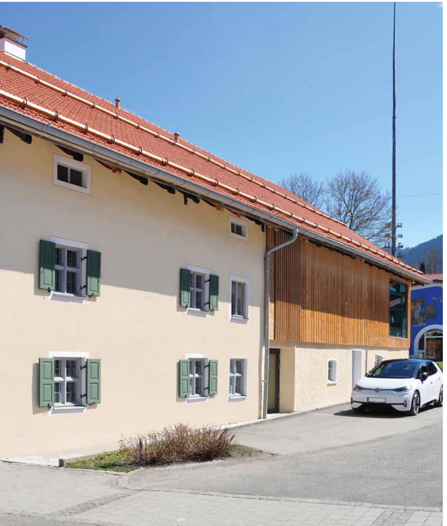
Lamplhof von Westen mit dem neuen Eingang zwischen Wohn- und Wirtschaftsteil
