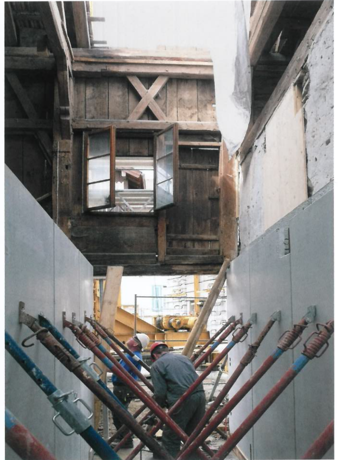
Oben: Betonarbeiten für den Versorgungskern im ehemaligen Wirtschaftstrakt. Copyright: Prof. Christian Schiebel
